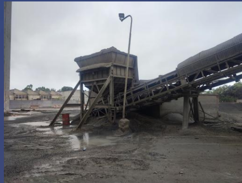
Tolva alimentación Clinker banda
